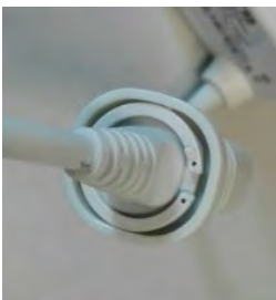
Der Sperring montiert
